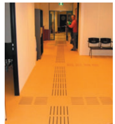
Bandes podotactiles au sol permettant aux non-voyants ou malvoyants de se repérer au sein de l'établissement
